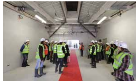
Le couloir d'entrée des joueurs et son puits de lumière
