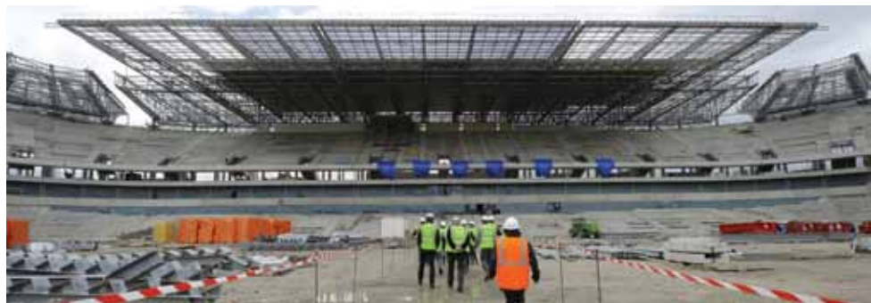
En direction du Rez-de-chaussée de la tribune Ouest
