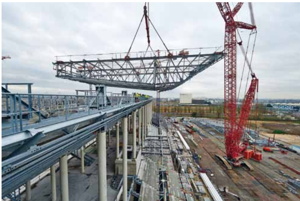
La pose du toit a débuté le 20 février 2014 et se terminera fin juillet.
