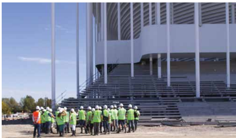
Premier point de la visite au niveau de l'angle Nord-Ouest
